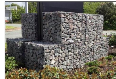
Les gabions sont généralement constitués d'un tissage de fils métalliques et remplis de pierres non gélives. Le plus souvent utilisés dans les travaux publics et le bâtiment pour construire des murs de soutènement, des berges artificielles non étanches ou décorer des façades, l'intérêt des gabions est avant tout une bonne tenue, une facilité de mise en œuvre et un caractère modulable.
