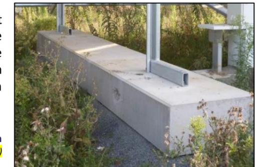
Figure 8 : Types de fondation - semelle béton
